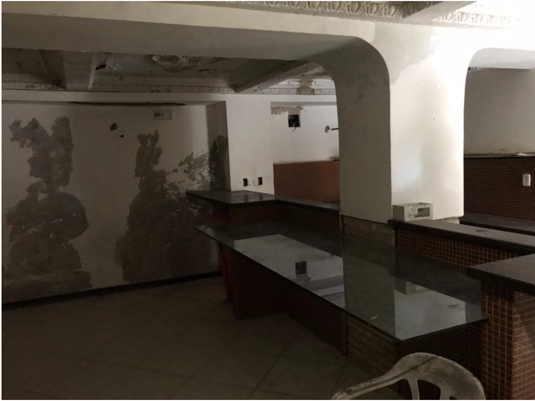
Foto 07: Cozinha, detalhe estado de conservação
