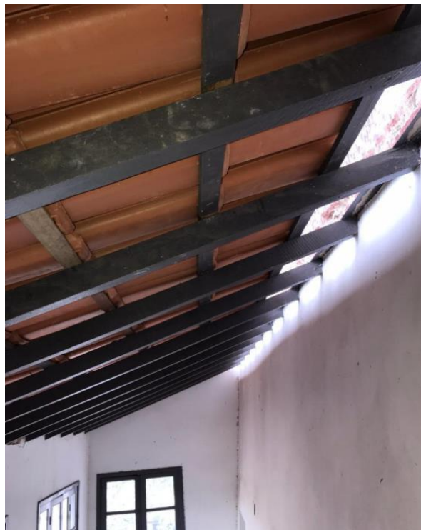
Foto 20: Cobertura telha cerâmica tipo colonial.
