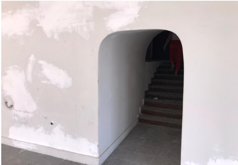
Foto 13: Entrada e escada de acesso ao pavimento
